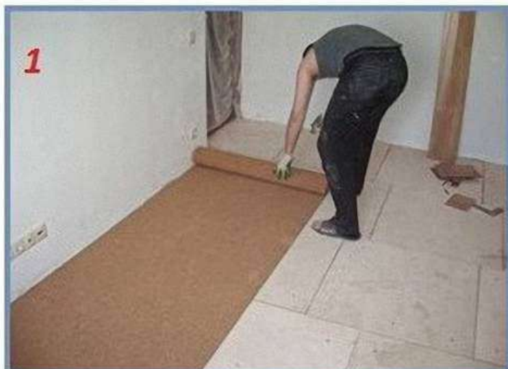
1 - раскатываем рулон пробки, не забывая о технологическом отступе 0,8-1,0см;
