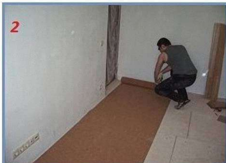
2 - обрезаем материал строительным ножом или обычными ножницами;
