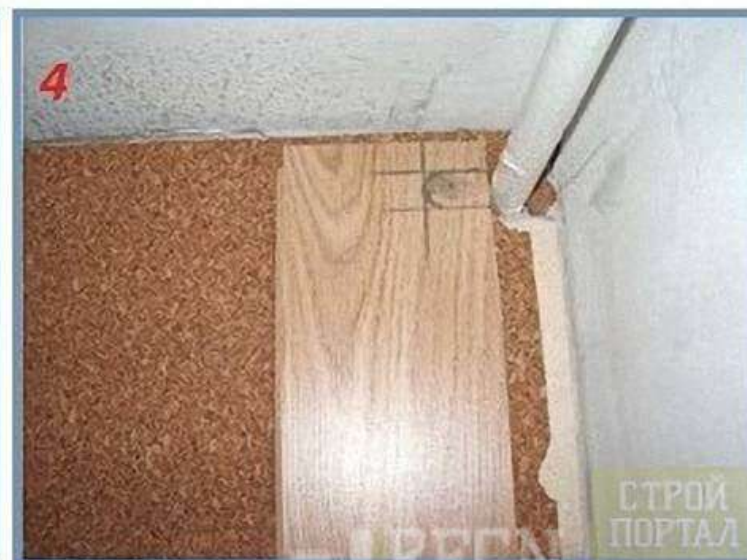
4 - укладка возле труб;
